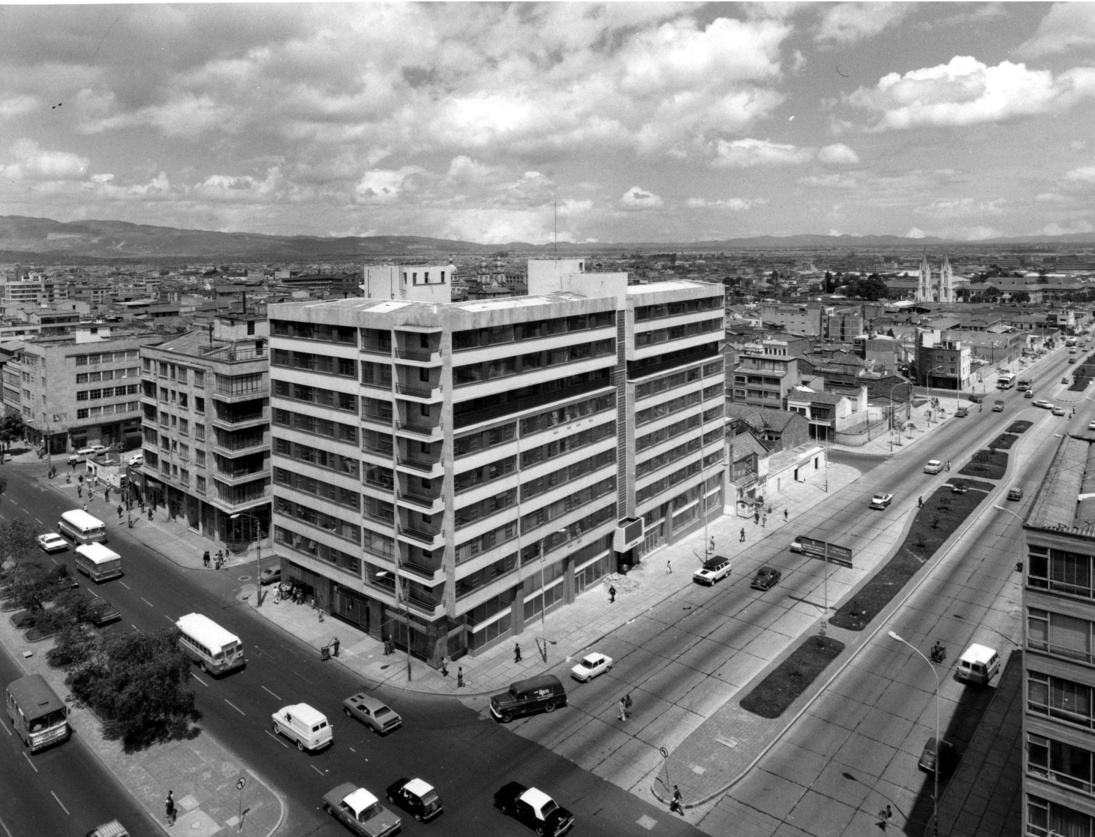
El Edificio CUDECOM en su localización final. La Avenida 19 es una arteria importante de la Ciudad de Bogotá
